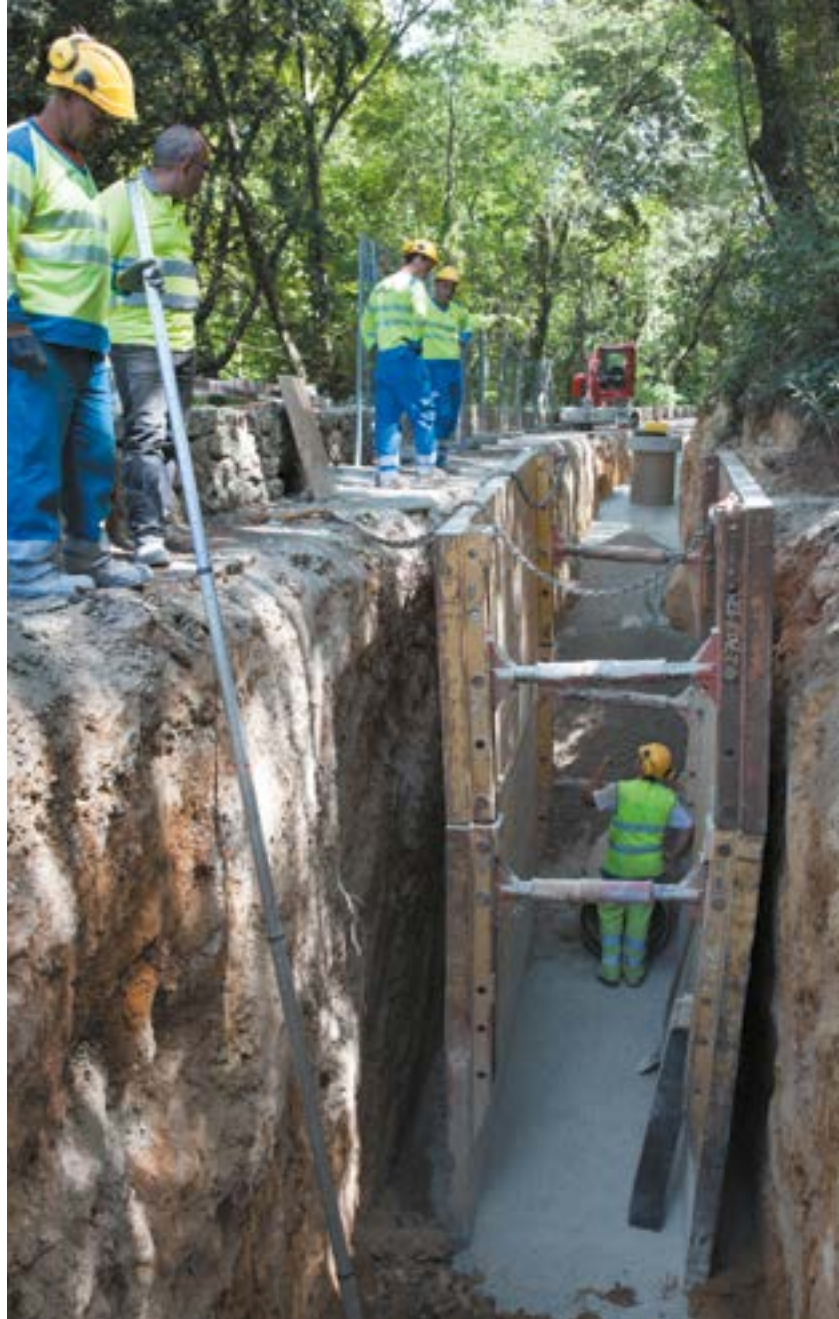
Sur la rue de Ferran, le long du parc Méric, la pose de l'intercepteur Est sera terminée fin octobre.
