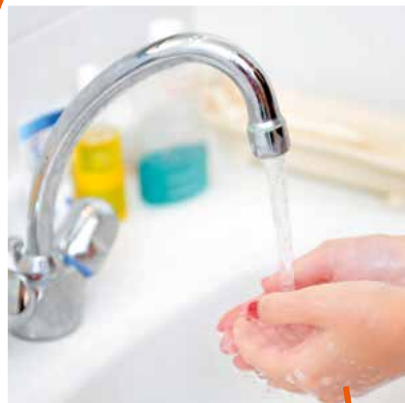
La municipalité de Castelnau-le-Lez utilise des réducteurs de débit sur tous les points d'eau de ses bâtiments.
