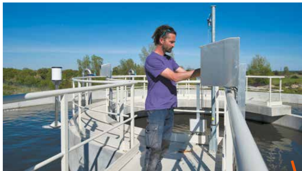
La station d'épuration de Cournonterral et Cournonsec, réhabilitée en 2005, a été modernisée et sa capacité doublée (à 15 000 habitants), de façon à répondre aux besoins futurs sans générer d'impact sur l'environnement. Livrée en avril dernier, cette station a coûté 4 M€.
