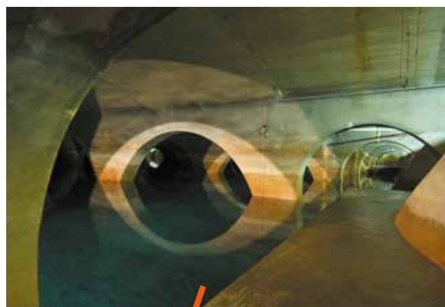
Le réservoir d'eau potable de Montmaur.
