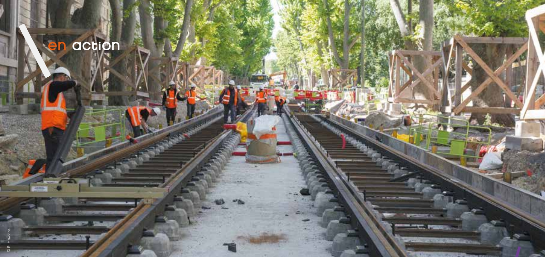
La pose des rails est en cours sur le boulevard Henri IV dans un environnement patrimonial d'exception entre la Faculté de Médecine et le Jardin des Plantes.
