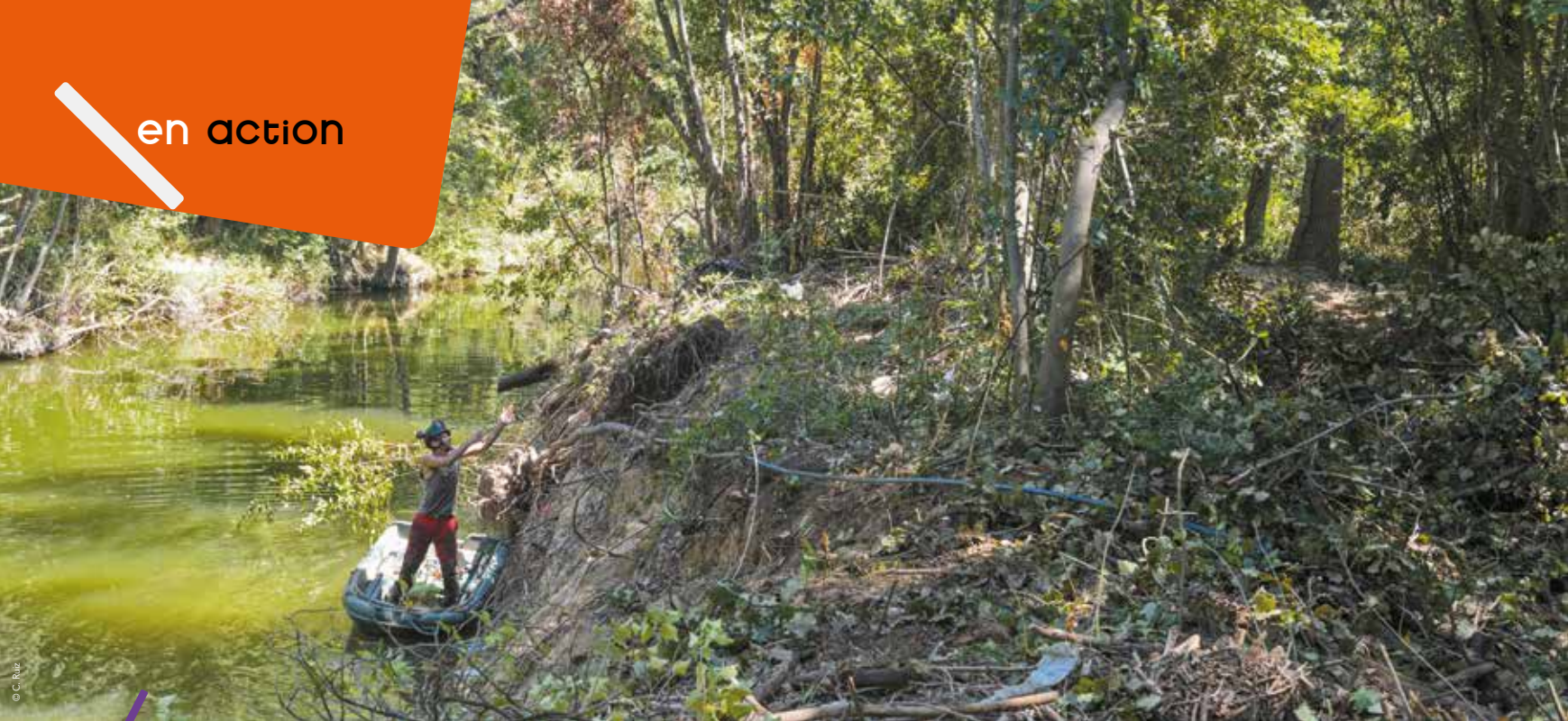
Les berges de la Mosson à Juvignac ont été nettoyées pour un meilleur écoulement des eaux.
