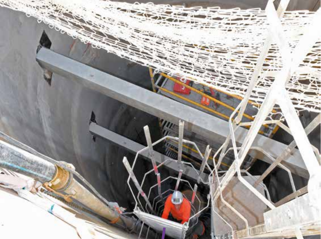
Deux puits de 14 mètres de profondeur ont été creusés.
