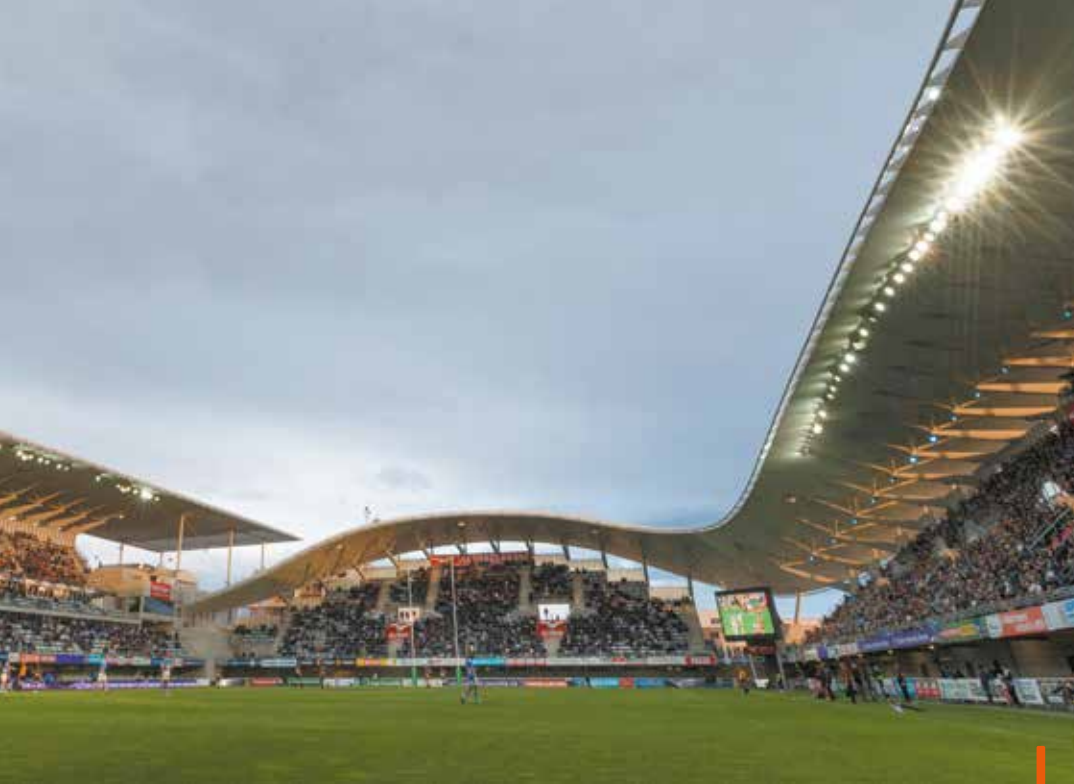
L'Altrad Stadium sera équipé de 80 projecteurs supplémentaires pour la reprise du Top 14.
