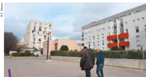
La rénovation du quartier de la Mosson (Montpellier) est l'un des deux chantiers prévus dans le cadre du projet de renouvellement urbain porté par la Métropole.
