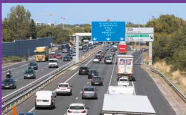
Le déplacement de l'A9, préalable au contournement routier, sera mis en service en 2017.
