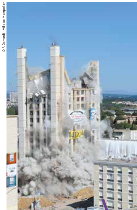
165 logements ont été reconstruits depuis la destruction de quatre tours à la Mosson.
