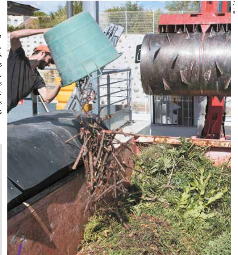
La nouvelle déchèterie de Castelnau-le-Lez est équipée de huit quais de déchargement, d'espaces de circulation agrandis et de dispositifs de protection des usagers.
