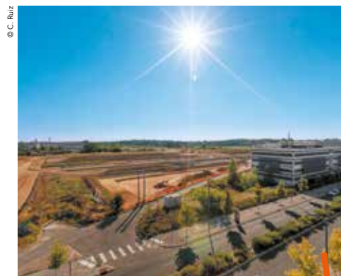
Le quartier Eurêka, en construction à Castelnau-le-Lez, offrira de nouveaux débouchés aux entreprises souhaitant s'installer dans la métropole.
