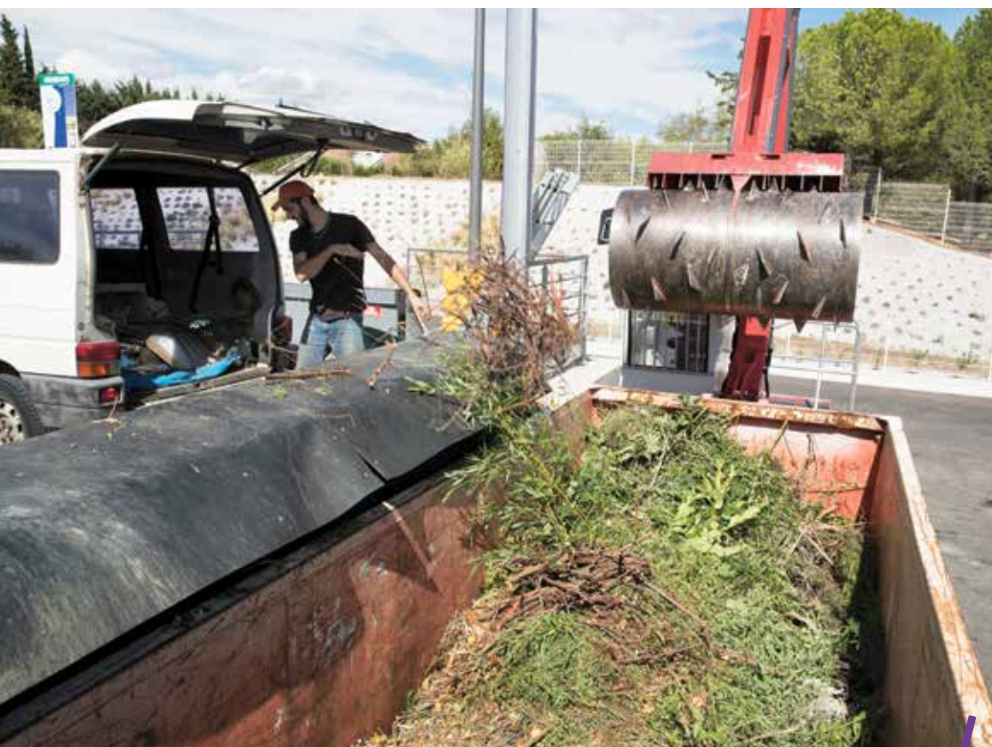
Les travaux d'extension et de rénovation de la déchèterie de Castelnau-le-Lez inaugurée en novembre 2015 servent de référence pour la rénovation des 19 autres déchèteries.
