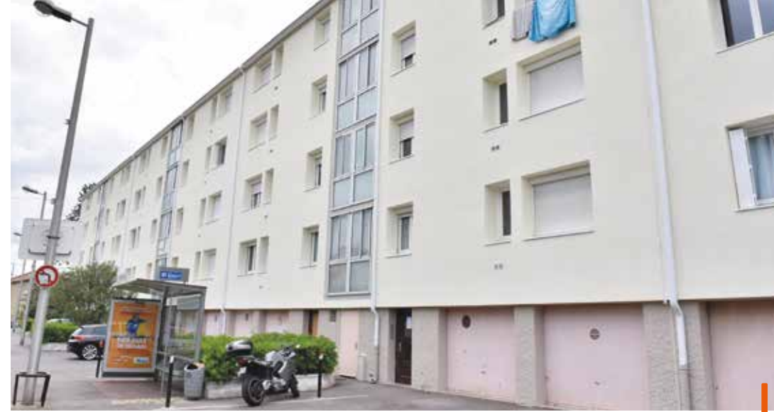
À Castelnau-le-Lez, 44 copropriétaires de la résidence Les Mandrous ont bénéficié de subventions pour rénover leurs logements. Pour partager cette expérience d'isolation par l'extérieur, l'Agence locale de l'énergie organise une visite ouverte au public le mercredi 14 juin (ale-montpellier.org).
