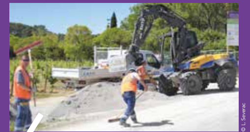
Ces nouveaux aménagements seront mis en service avant la fin du mois de juin sans interruption du service pour les usagers.
