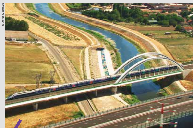
Entre juillet et septembre, les essais de montée en vitesse ont notamment permis de tester l'infrastructure du viaduc de 90 mètres surplombant le Lez et la Lironde.
