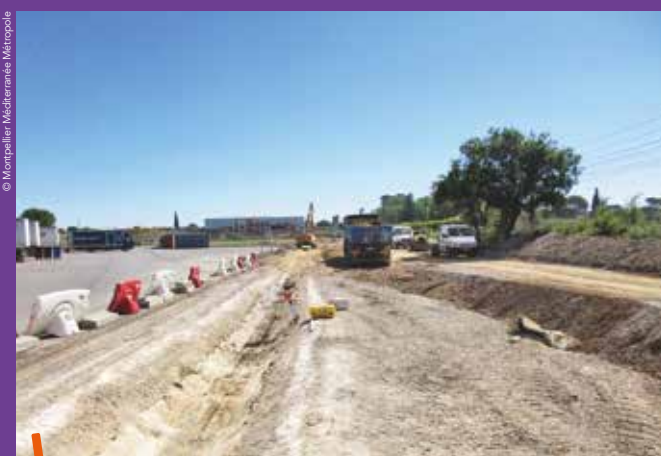
Un des derniers chantiers de lutte contre les inondations : la construction de la digue de la Cadoule protégeant la zone d'activités de Massane à Baillargues.
