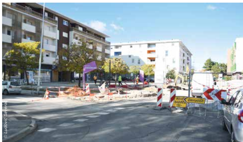
Les travaux d'aménagement financés par Montpellier Méditerranée Métropole battent leur plein.
