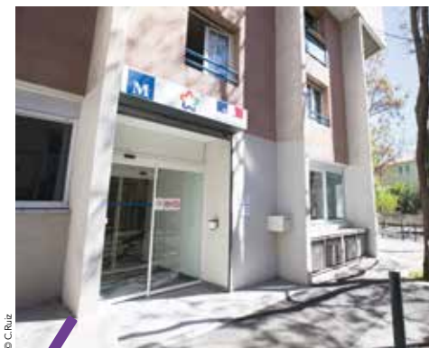
Après celle de Celleneuve à Montpellier (photo), une maison de la justice et du droit va voir le jour à Boirargues sur la commune de Lattes.
