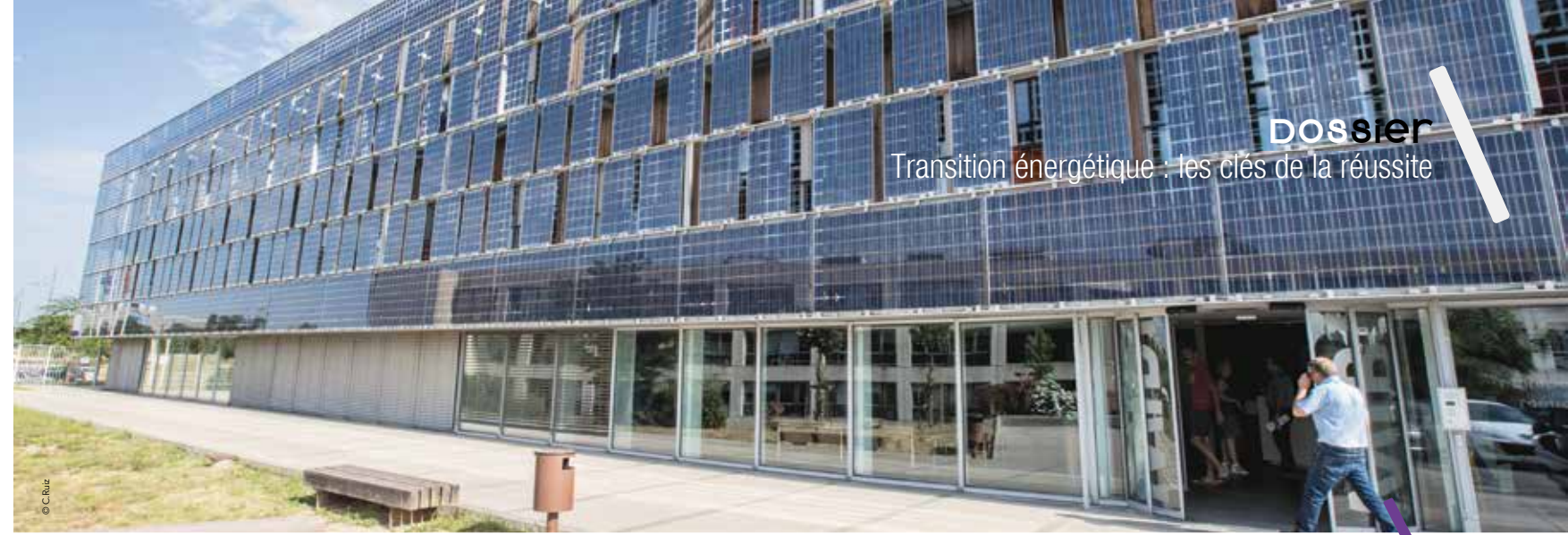
La façade du MIBI produit 76 MWh/an d'électricité verte, grâce à ses panneaux photovoltaïques. Soit une économie de 16 tonnes de CO 2 /an.
