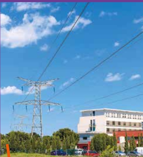
La mise en souterrain de quatre lignes à haute tension sera réalisée entre l'autoroute A709 et le domaine de Verchant, en passant par Port Marianne et la clinique du Millénaire (photo).
