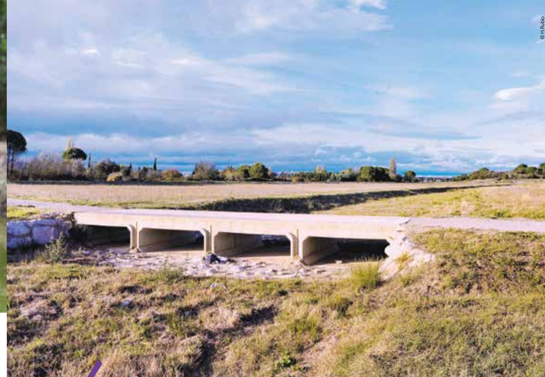
Parmi les travaux opérés à Lattes, la plaine de la Lironde a fait l'objet d'une attention particulière avec la réalisation d'aménagements anti inondation pour un meilleur écoulement des eaux en période de crue.
