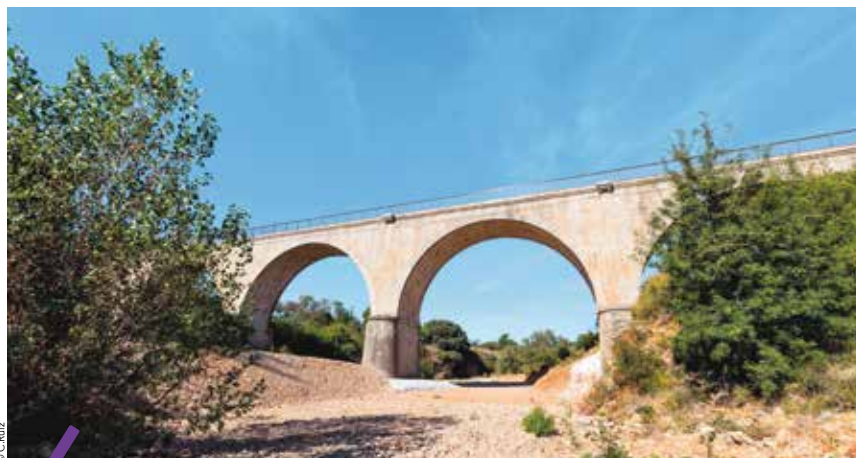
Sécurité et esthétique assurés avec la rénovation du pont créé en 1872 à Cournonterral.
