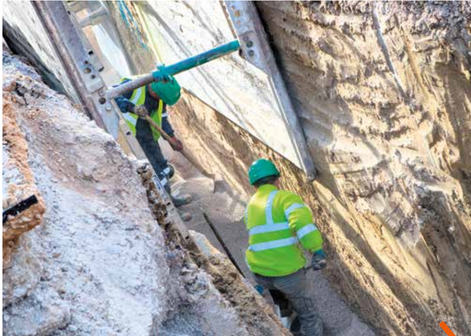
Des travaux d'assainissement financés par la Métropole sont programmés cette année au Crès.
