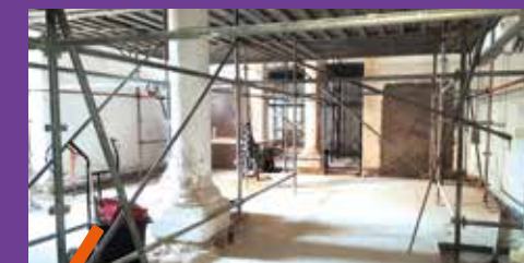
Le château de Castries connaît d'importants travaux intérieurs.
