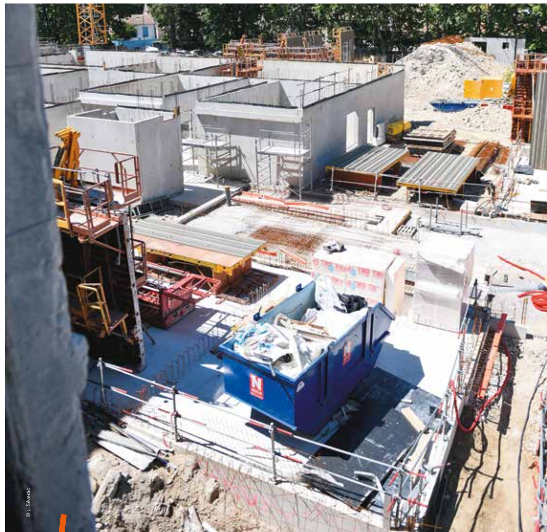
Les premiers modules qui accueilleront les salles d'enseignement sortent de terre.
