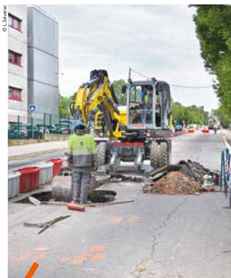
Les travaux sont engagés dans le secteur nord du tracé.
