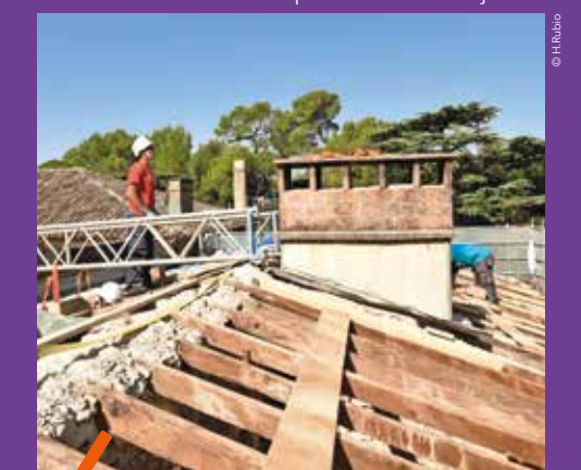
À Méric, la vaste campagne de restauration débute par la toiture.
