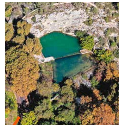
La source du Lez, lieu de captage de l'eau potable.
