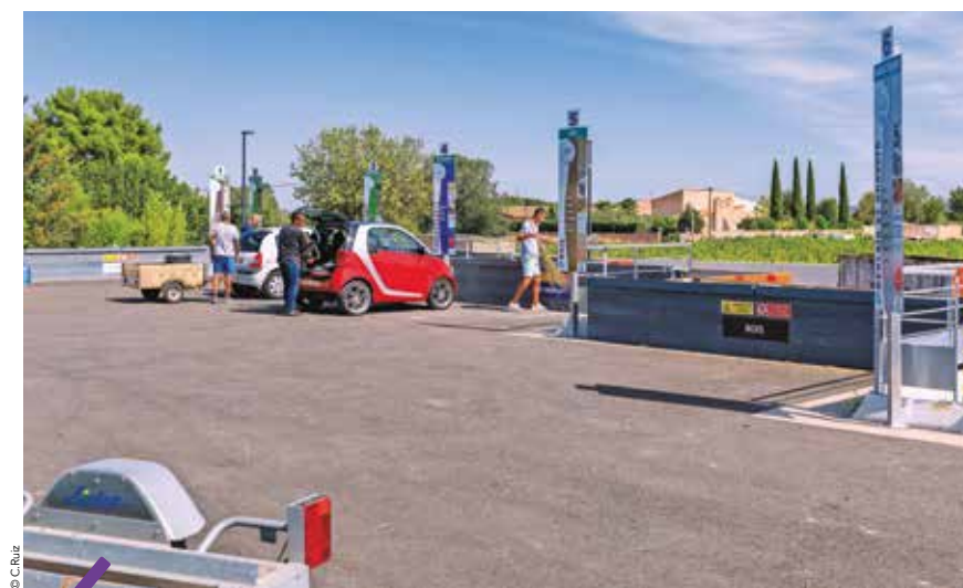
La déchèterie de Courmonterral, dont les travaux ont duré quatre mois, a été inaugurée le 24 septembre.
