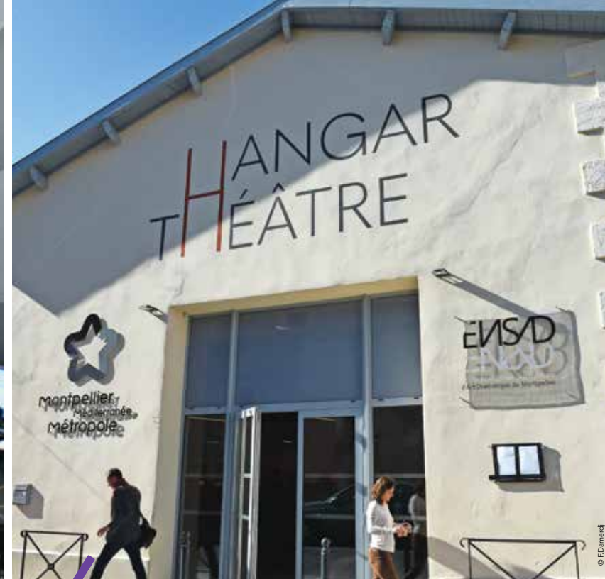
La signalétique extérieure a été renforcée pour marquer la présence du théâtre à Boutonnet. Le hall d'accueil, rénové et agrandi, se transforme en foyer des artistes pendant les résidences de création.
