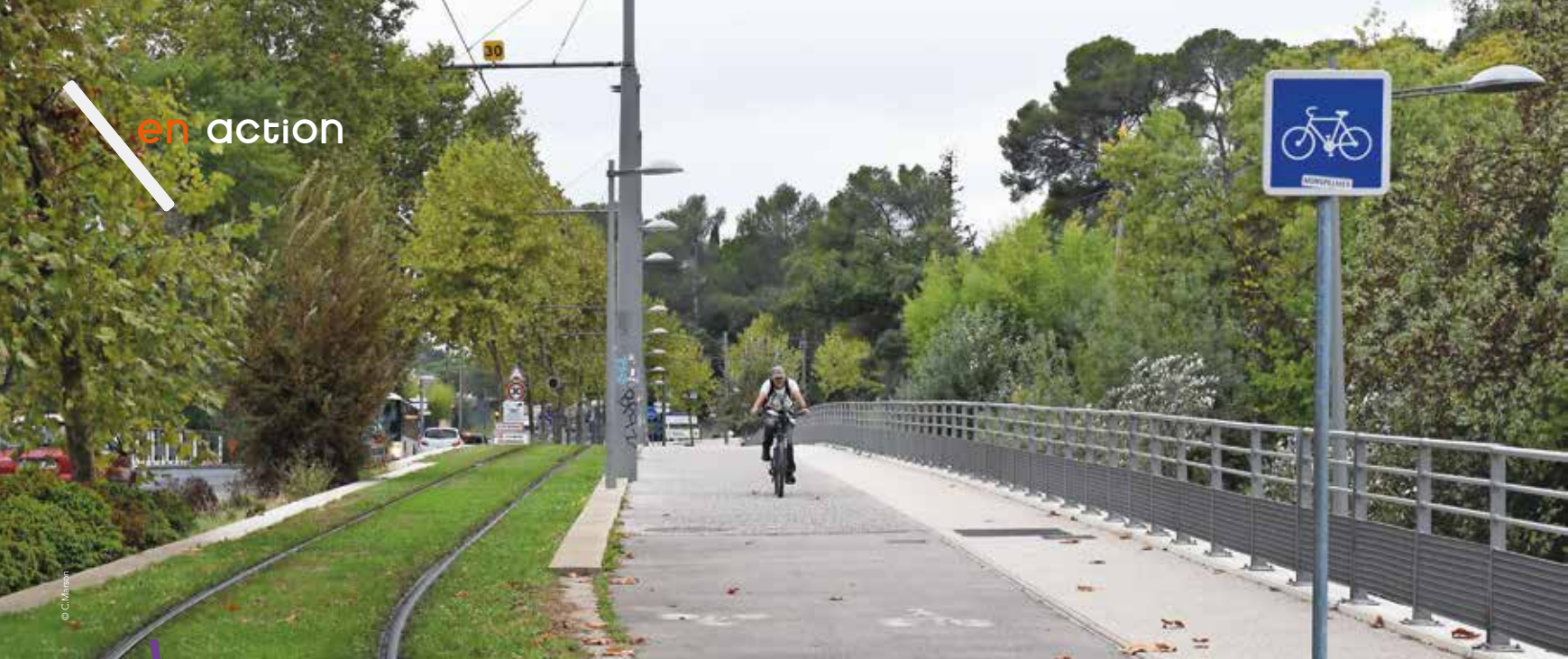
Une piste cyclable à double sens a été aménagée avenue de Lodève à Montpellier.
