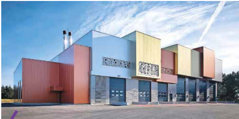
La 1 re centrale trigénération de France située dans le quartier Port Marianne à Montpellier est appelée à alimenter 10 000 logements dans les années à venir. Elle produit à la fois chaleur, froid et électricité, avec du bois local (moins de 100 km), une énergie renouvelable, moins chère que l'énergie fossile.
