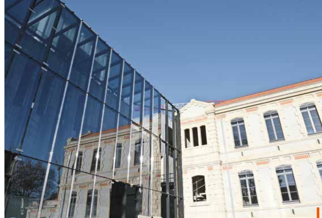
L'ancienne maternité Grasset réhabilitée a été étendue par une construction moderne en verre.
