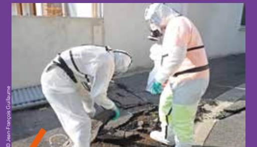
La Métropole change les canalisations en amiante dans les communes.
