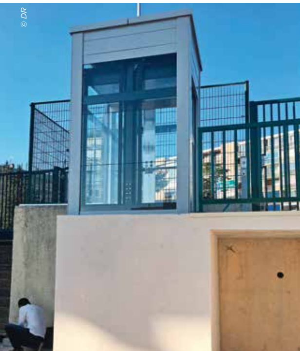
Un ascenseur a été aménagé sur le site du stade Philpidès.
