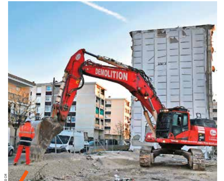
Le dernier coup de pelle de la démolition de la barre d'immeuble D a été donné le 9 janvier. Engagés en 2016, ces travaux marquent la fin du vaste chantier du Petit Bard. La remise en état du terrain est prévue en mars. Au total, ce sont 462 logements qui ont été détruits selon le programme défini en 2005 avec l'ANRU pour rénover ce quartier de Montpellier.
