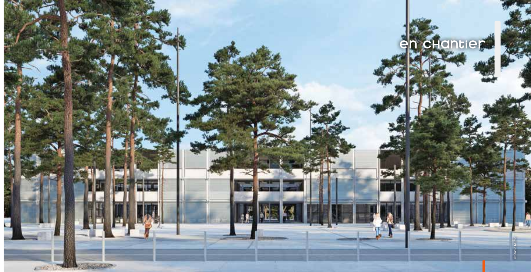
La halle dédiée à l'innovation pourra accueillir une cinquantaine d'entreprises.
