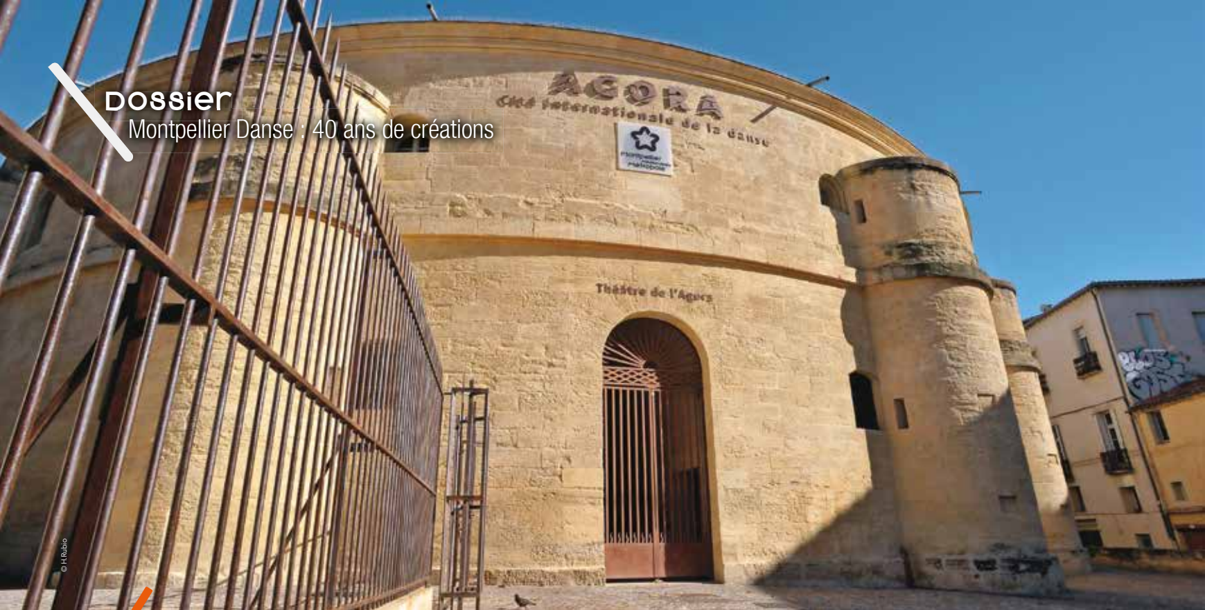
L'Agora, cité internationale de la danse située boulevard Louis Blanc, est un lieu de rencontre entre la danse et le public. La structure est desservie par les lignes de tramway 1 et 4.
