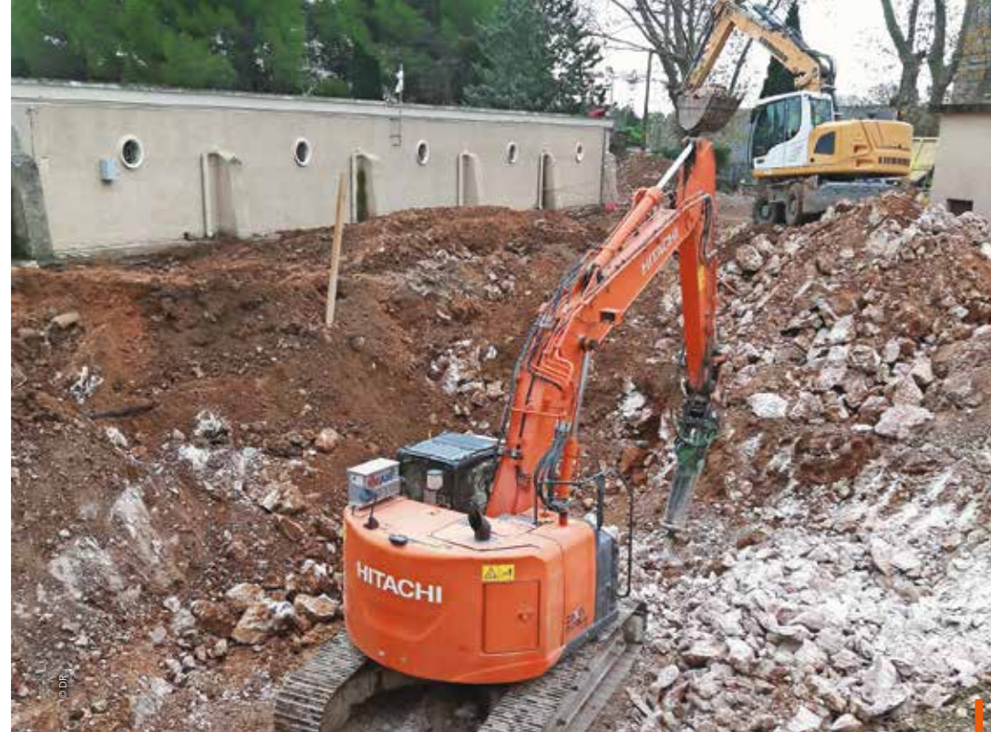
Après les travaux de démolition, une nouvelle station de pompage d'une plus grande capacité de remplissage est en construction.
