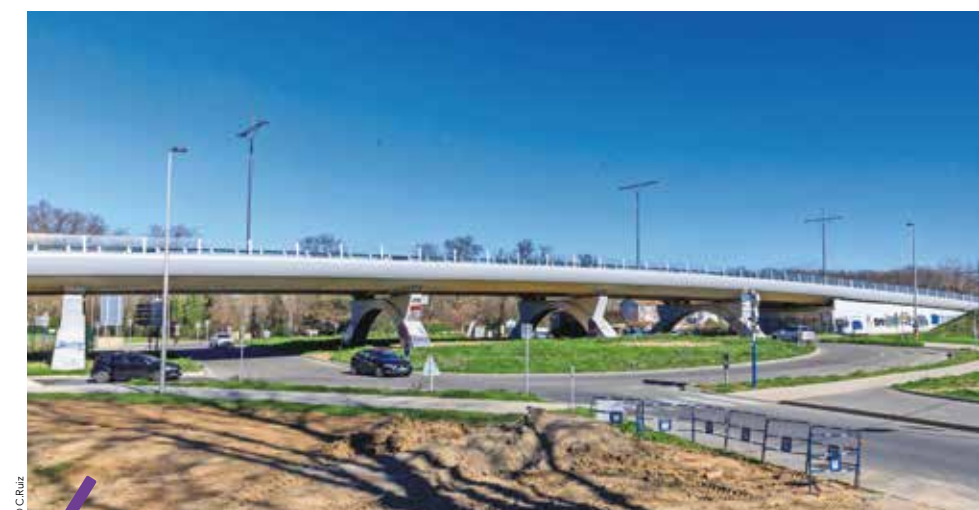
Le pont André Vezinhét verra passer sous son arche la ligne 5 de tramway.
