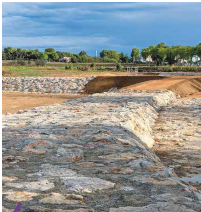
À Clapiers, l'un des derniers aménagements de protection contre les inondations réalisé par la Métropole.
