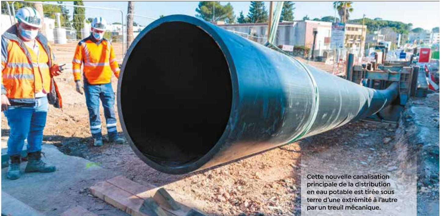
Cette nouvelle canalisation principale de la distribution en eau potable est tirée sous terre d'une extrémité à l'autre par un treuil mécanique.
